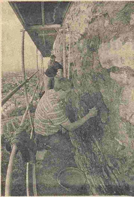
Viel handwerkliches Geschick verlangt die Arbeit an der Burg von den Restauratoren.
