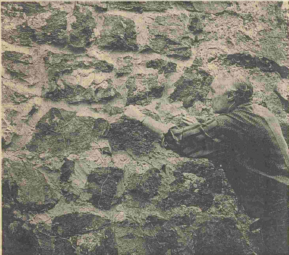
Burgherr Helmut Lauer vor der Westmauer: Bis auf 15 Zentimeter Tiefe muß der alte Mörtel entfernt und die Zwischenraum zwischen den Findlingen neu verfügt werden.
